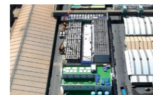
1공장 냉각탑 설치 작업 진행 현장
